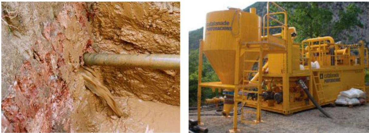
Figura 5. Fluido de perforación y central de tratamiento de lodos.
