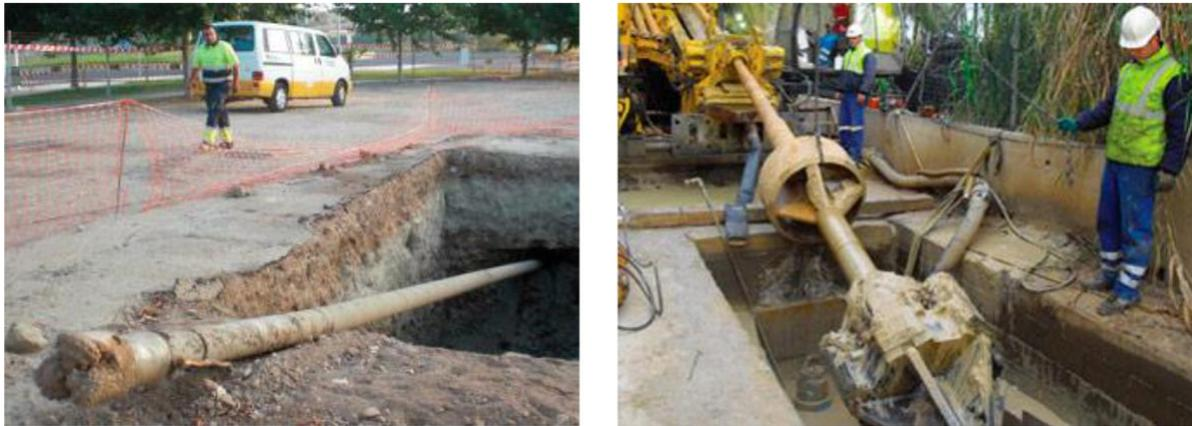
Figura 3. Cabeza de perforación y escariador.
