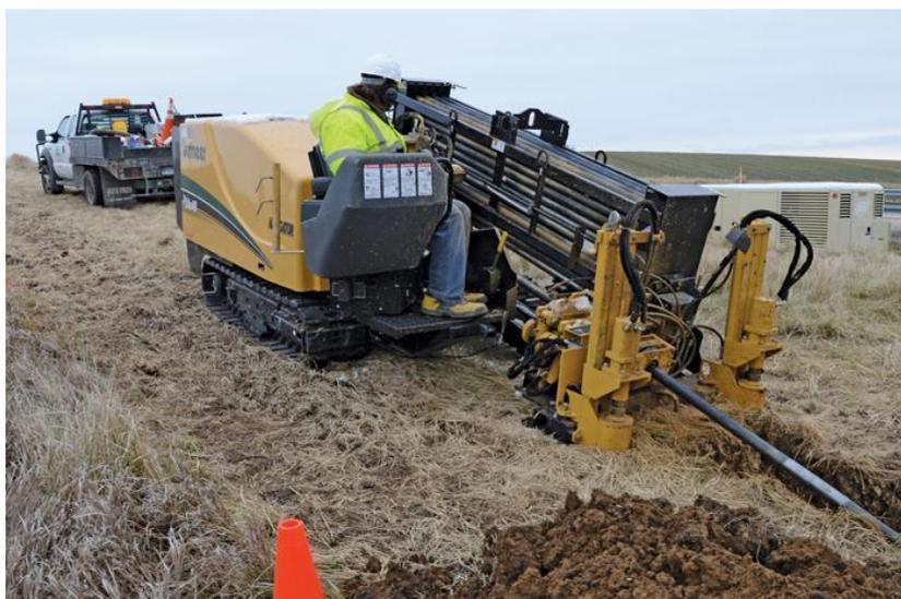
Figura 10. Sistema de carga de tramos de tubería. .
