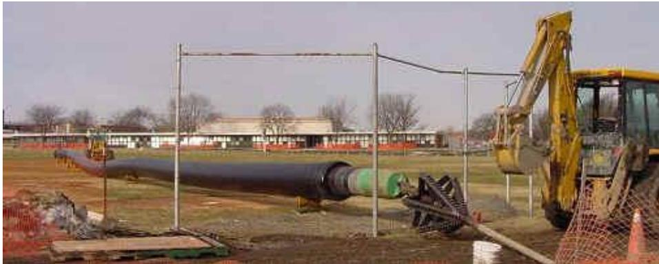
Figura 9. Conexión del escariador a la tubería. .
